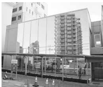
教育ステーション機能等増築棟 (坂病院)
